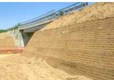
Rilevato stradale di sottoscampa in terre rinforzate FAST-TER
