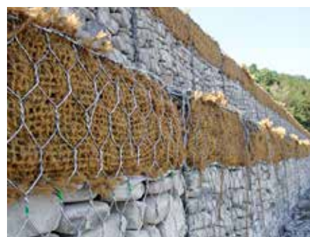
Particolare del gabbione verde dopo la sua realizzazione
