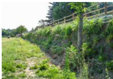
Impiego del sistema preassemblato FAST-TER nella realizzazione di una pista ciclabile in allargamento stradale di sottoscampa
