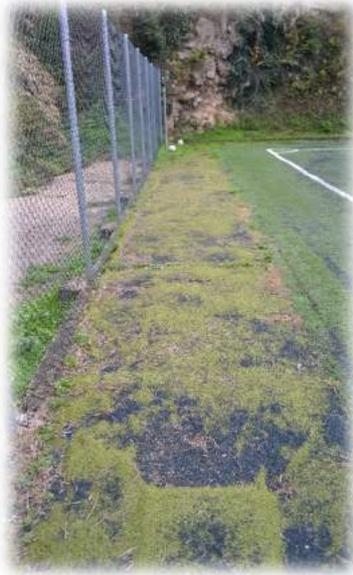
Recinzione in rete metallica e sostegni metallici con cordolo cemento
